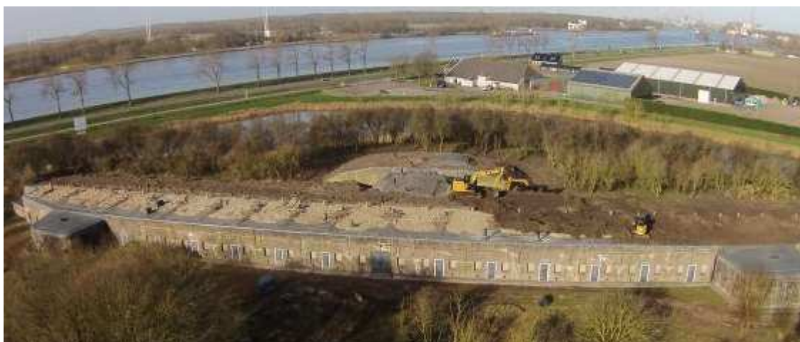
Figuur 1: Nieuwe afdekking van het dak.
