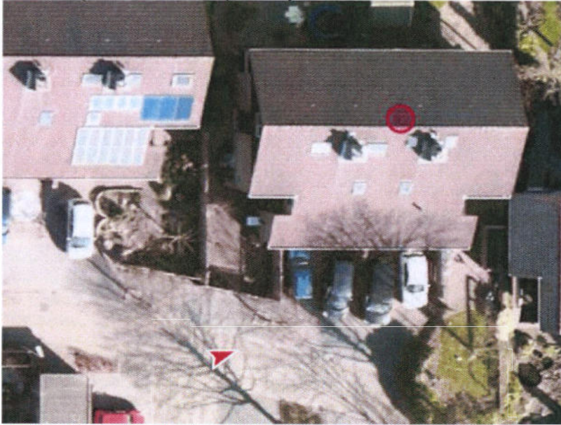
Afbeelding 4: luchtfoto oorspronkelijke situatie
