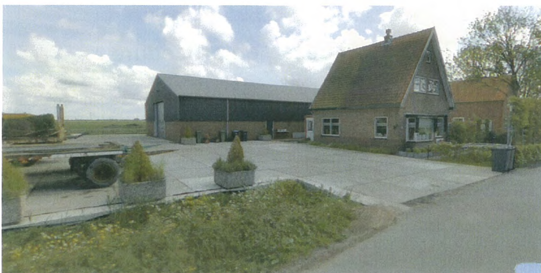
Foto bestaande situatie
