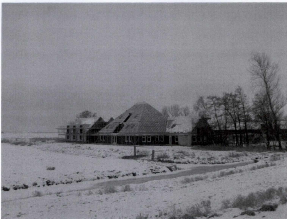
Foto tijdens de bouw Herbergier
