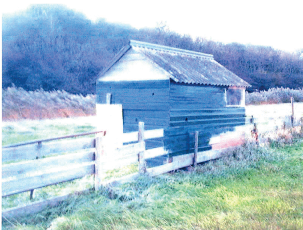
Schuurtje met asbestdak, op boezemdijk, aan de zuidgrens van de locatie
