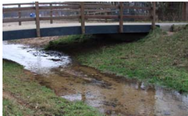
Schoonwaterloop Scheybeeck Beverwijk Bron: Advies Arda
