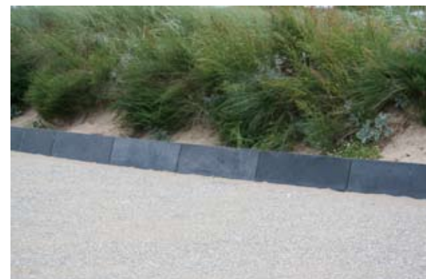
Nollen langs ontsluitingsweg
