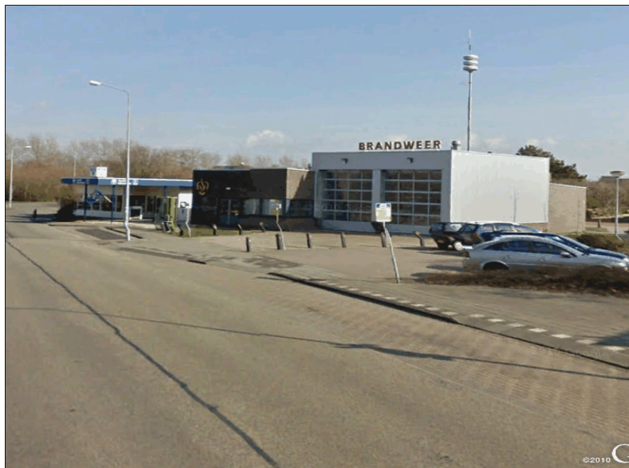
Figuur 3. Brandweer en VVV-kantoor, gezien vanaf de Jewelweg (Bron: Google Earth)
