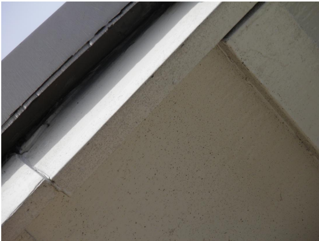
Detail aansluiting kantpannen. Naad is afgekit.
