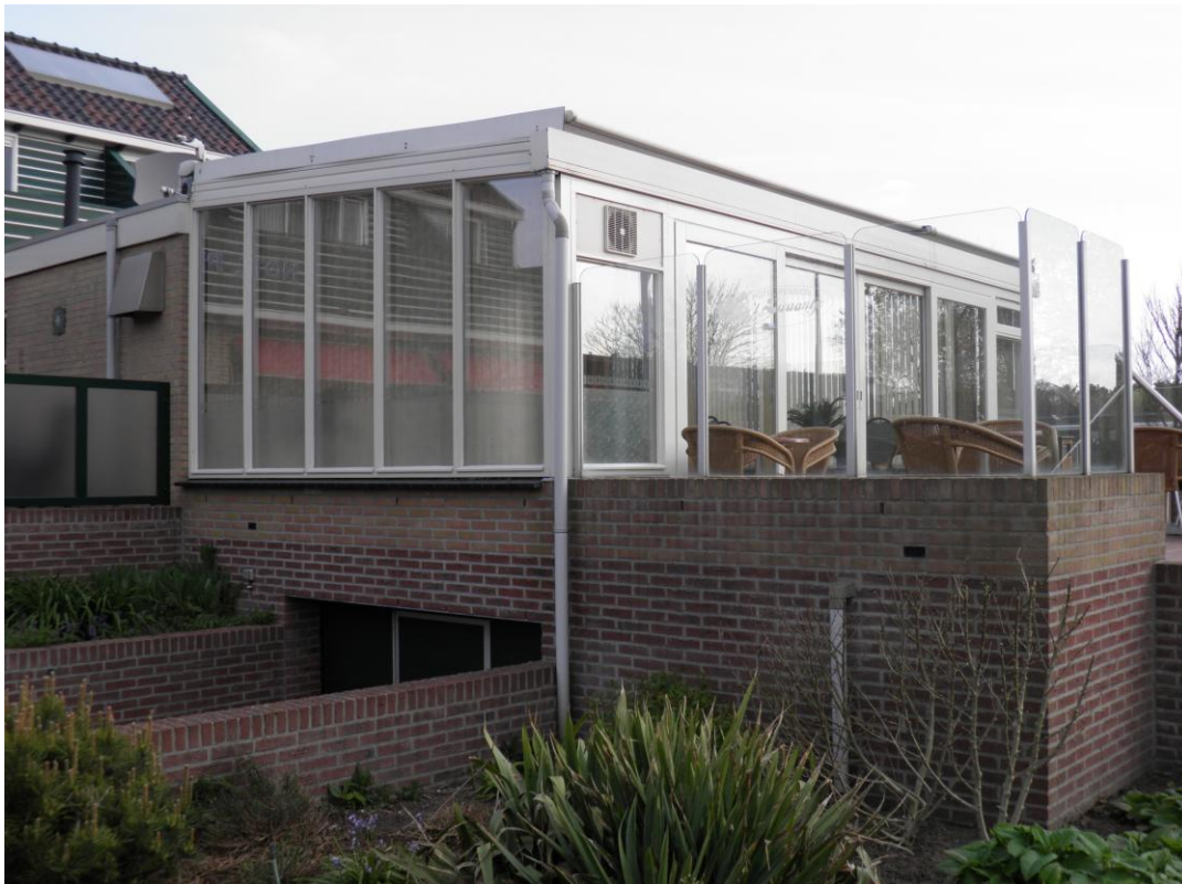
Serre linker zijgevel
