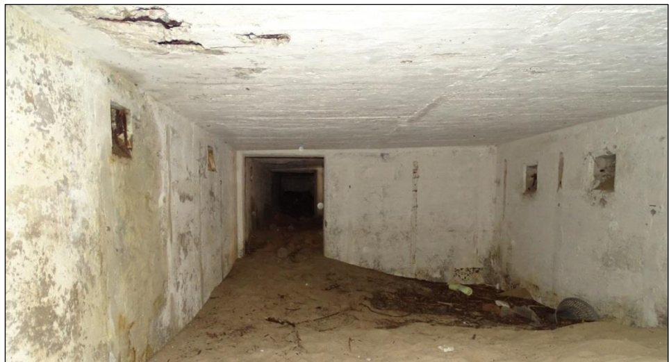
Figuur 4.10 Een voorbeeld van een scherfvrije, betonnen groepsschuilplaats net ten zuiden van Zandvoort (N. Warmerdam, BAAC). Deze is gedurende WOII opgenomen in de Atlantikwall.
