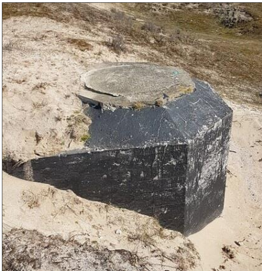
Figuur 4.11 Een zogenaamde betonnen Ringstand voor een mitrailleursschutter bij Stützpunkt XXXIX Luftwaffe Funksende Anlage 'Zander' (N. Warmerdam, BAAC).
