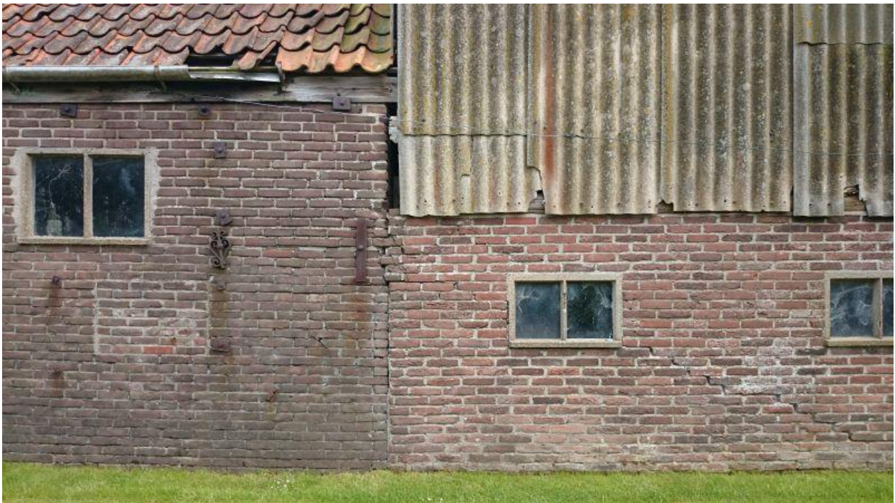
Gevel van de stal en kapberg aan de westzijde. Opvallend zijn de verschillende raamniveaus
