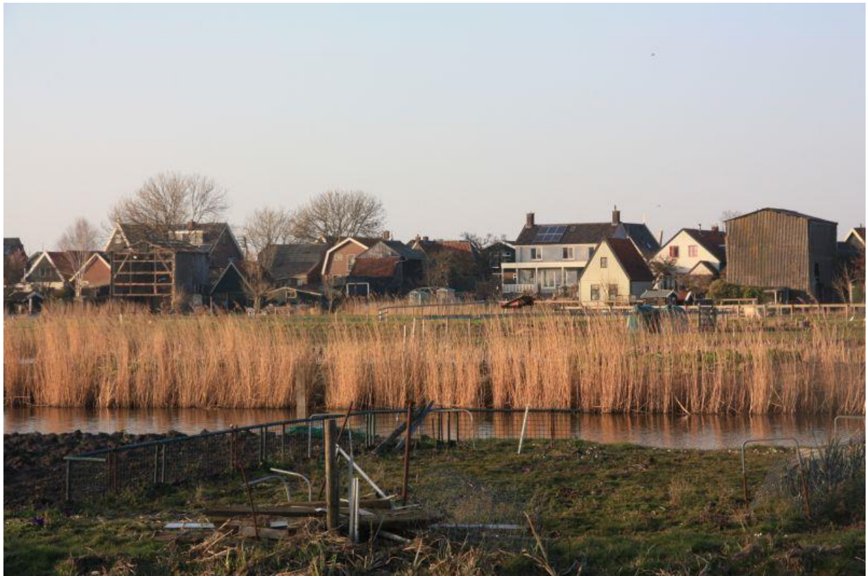
Zicht op het Westeinde, links de inmiddels afgebroken kapberg, rechts de kapberg aan het Westeinde 44 Foto door Bouwbedrijf Piet vd Burg
