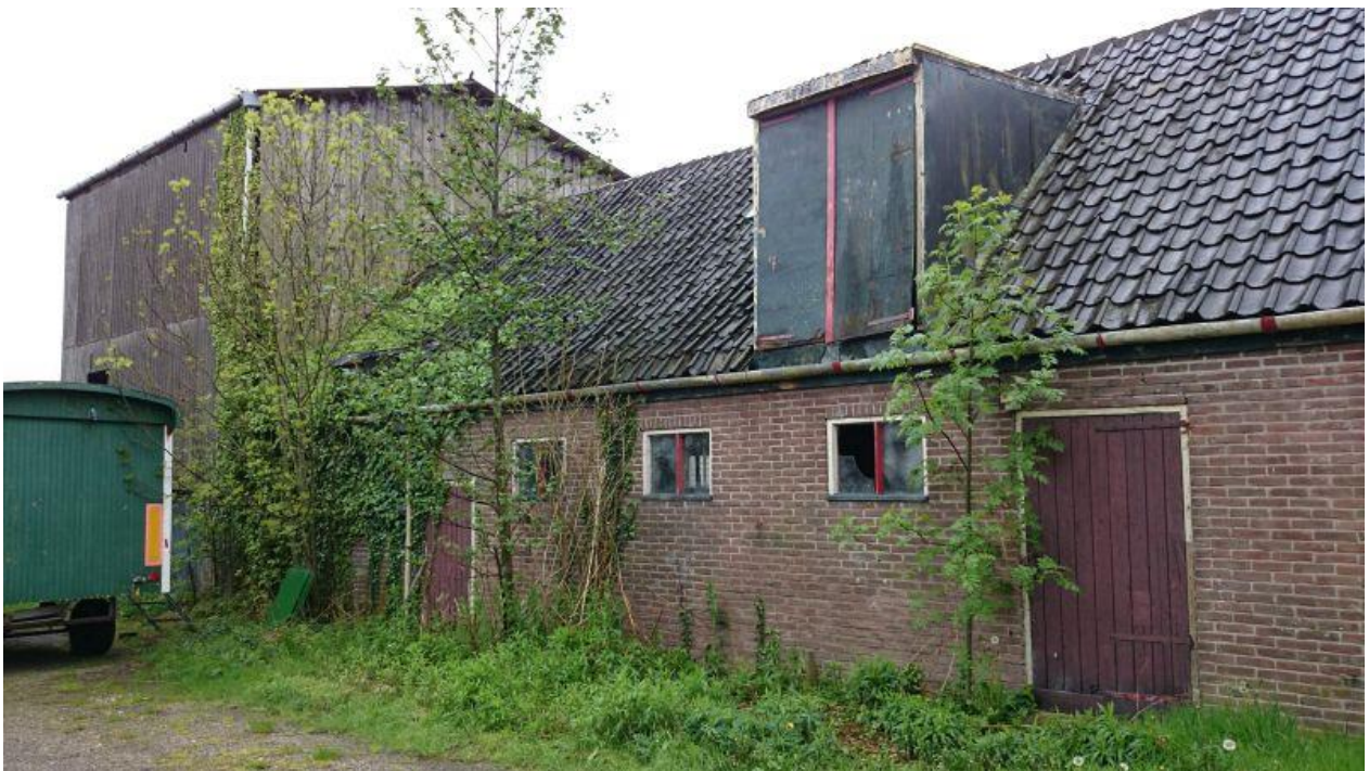
Stal en kapberg. Opvallend is het hoogteverschil van de toegangsdeuren naar de stal
