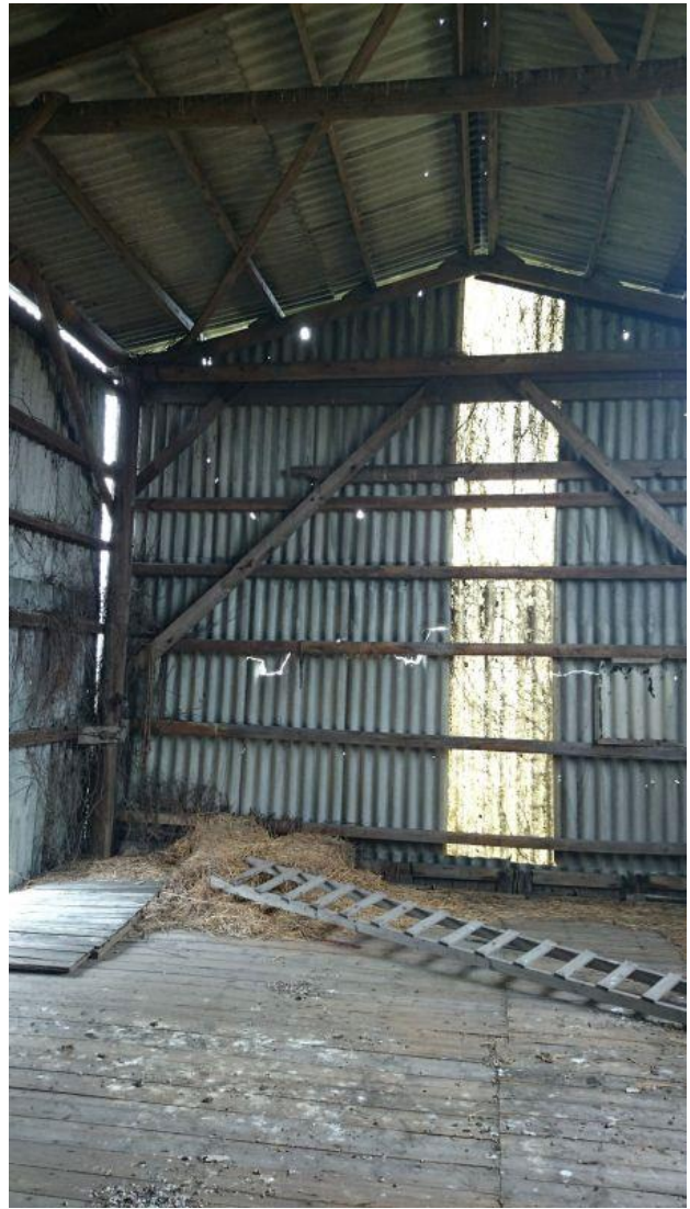
Zicht op het binnenwerk vanaf de verdieping
