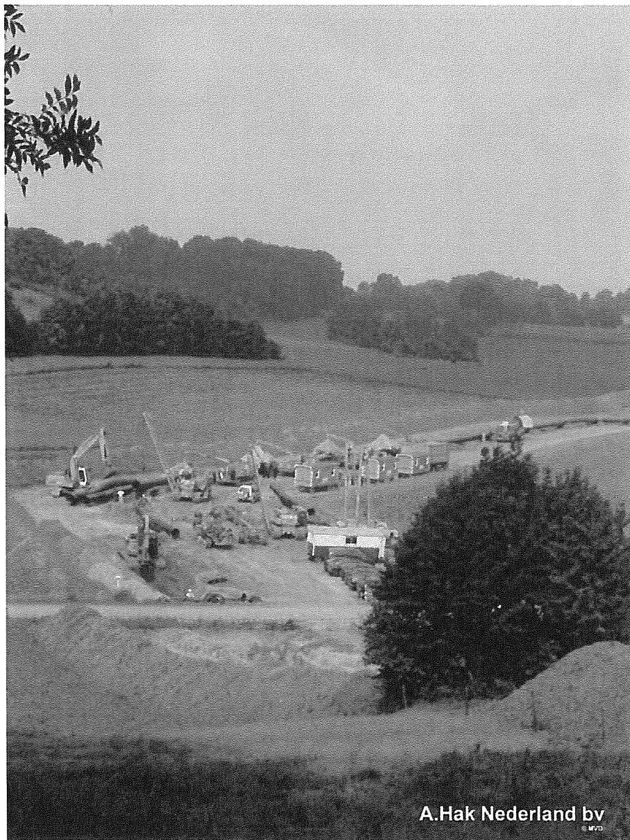
Bijlage 4: Foto met een typisch voorbeeld van het aanzien van een mobiele verblijfskeet
