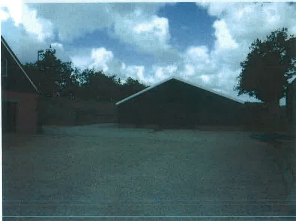
Foto 1: te slopen stallen
