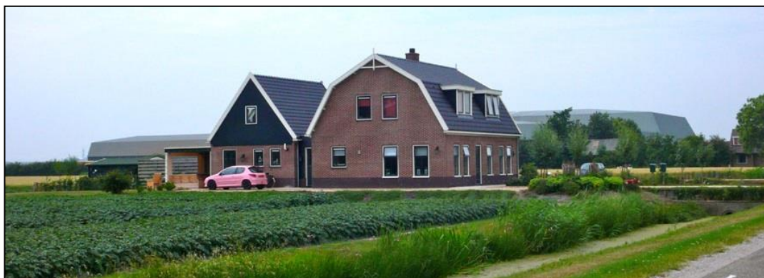
Foto 13, Een uitzondering is recent gerealiseerd. Deze woning (Molenweg 8 Ursem) wijkt op een aantal punten af van zijn voorgangers: het bouwdeel met mansardekap is breder dan de historische voorbeelden, er staat een bouwdeel tegenaan met zadeldak (wat een voor het gebied wezensvreemde ingreep is om toch een groot volume te realiseren) en in de mansardekap zijn aan de wegzijde twee grote dakkapellen aangebracht.
