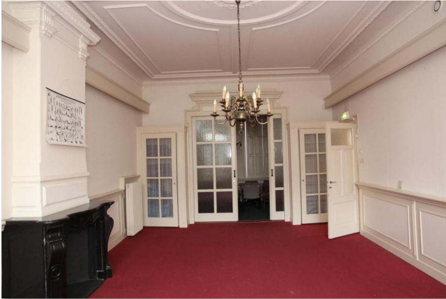
Afbeelding 8 – op diverse plaatsen zijn oorspronkelijke interieurafwerkingen (lambrisering, schouw, pafond, ensuite-indeling) aanwezig.
