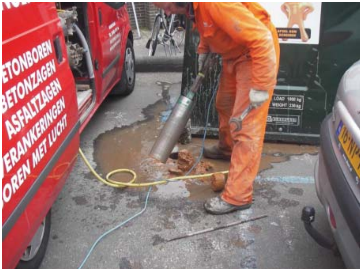
Figuur 13: De dikke laag in metselverband gelegen oranje baksteen zoals aangetroffen in (o.a.) boring 10.
