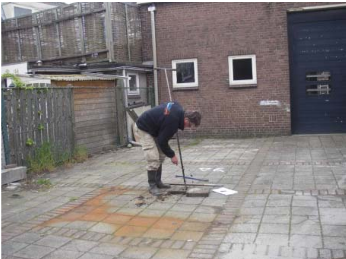
Figuur 12: Boren ter plaatse van boorpunt 5.
