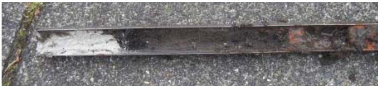
Figuur 14: De laag kalk die in boring 12 is aangetroffen met links hiervan de bovenliggende tuinlaag.
