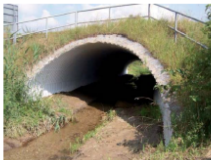
Eurorail plaatstalen duiker. Zonder doorgang of naast doorgang al een veel mooier alternatief dan een buis van 600 mm
