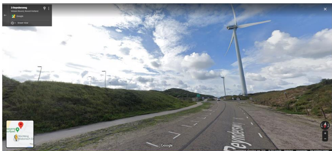
Figuur 4.3 Zicht vanaf de Reyndersweg
