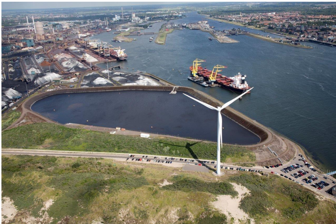
Figuur 3.2 Luchtfoto huidige situatie
