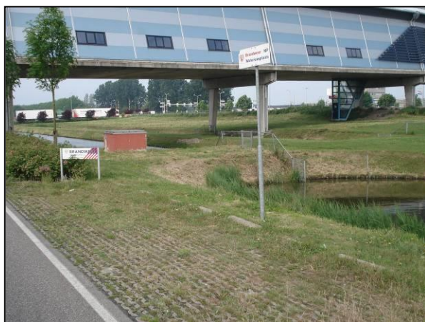
Afbeelding: waterwinplaats brandweer
