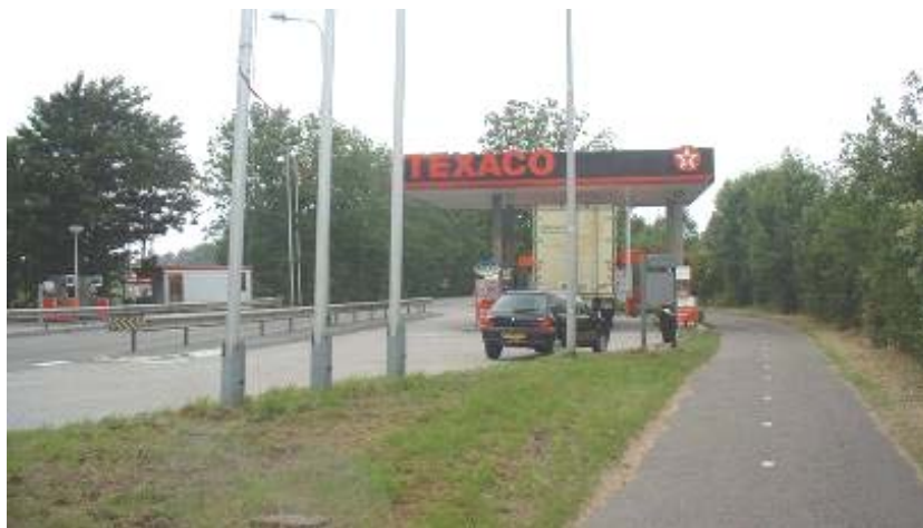
Het benzineverkooppunt aan de provinciale weg
