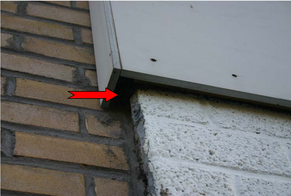
Figuur 4.2.5. Opening onder de betimmering die toegang geeft tot de spouw.
