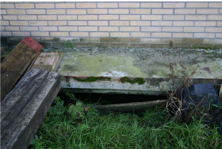
Figuur 4.2.6. Toegang tot de kruipruimte.
