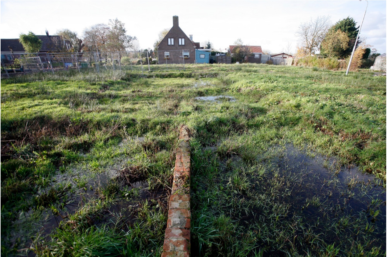
Afb.2: Ondiepe poel ontstaan in de achtergebleven fundering op perceel 1
