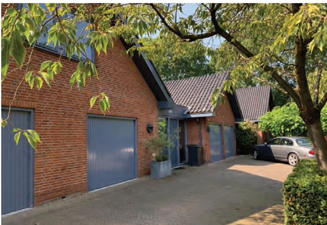
Foto's bestaande gebouwen
