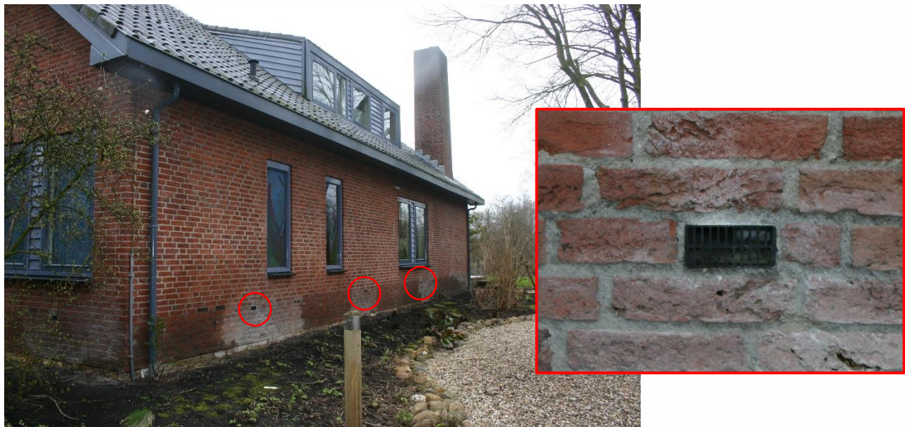
Figuur 4.4.6. De westgevel, waartegen de nieuwe garage wordt gebouwd, bevat geen open stootvoegen of ventilatiesleuven. Op kniehoogte zijn enkele openingen ter grootte van een halve baksteen aanwezig (rood omcirkeld) met een rooster ervoor.
