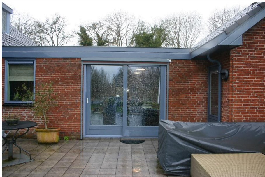
Figuur 4.4.2. In de te slopen achtergevel zijn geen openingen aanwezig die vleermuizen toegang bieden tot de spouw en de boeiboorden zijn strak tegen de gevel gemonteerd.
