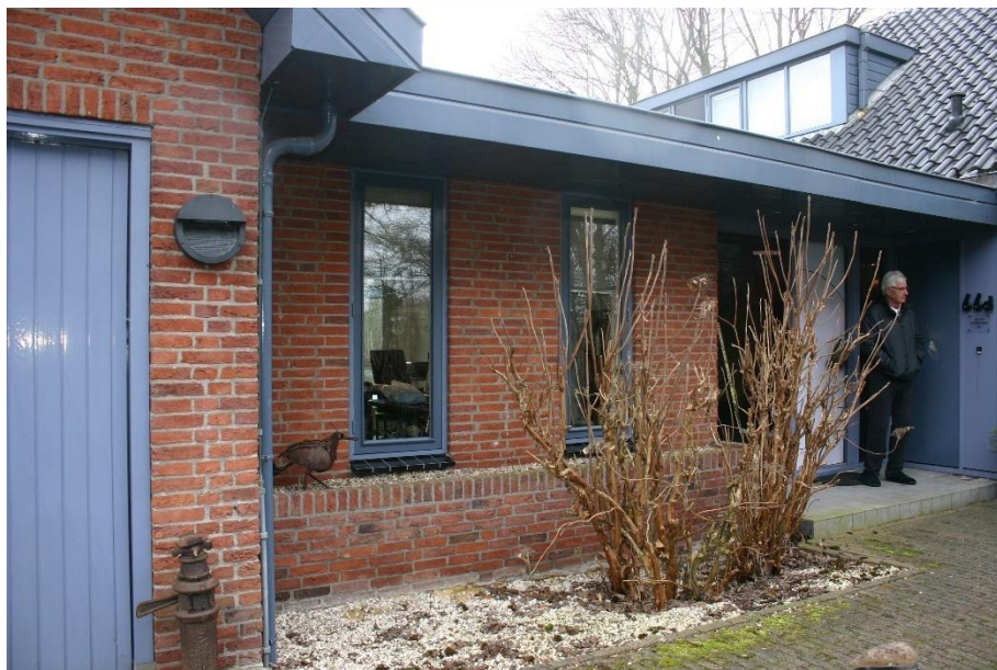
Figuur 4.4.3. De voorgevel van het te slopen deel bevat geen open stootvoegen of dergelijke.
