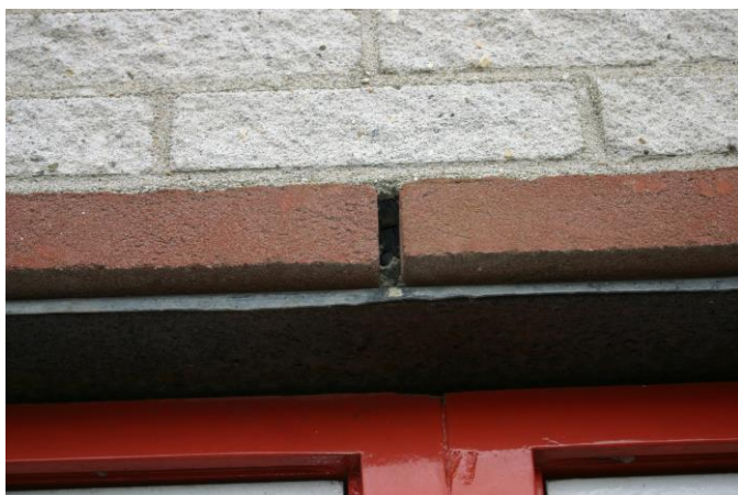
Figuur 4.5.1. Open stootvoeg in het grote hoofdgebouw van Euser.
