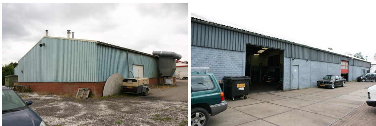
Figuur 4.1.2. Twee van de bedrijfsloodsen hebben golfstalen wanden en een golfstalen dak.
