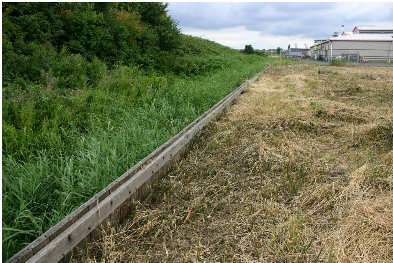
Figuur 4.5.3. Steile houten damwand tussen de noordwestelijke sloot en het plangebied.
