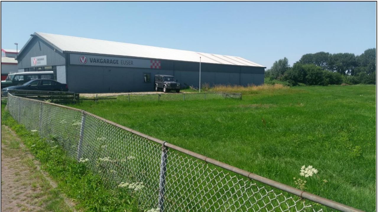
Figuur 8: Het noordelijke deel van het plangebied in zuidelijke richting, hier is geen puinverharding en ter hoogte van de geel verkeurde groenstrook rechts van de vlaggenmast is een steilrand aanwezig die de begrenzing duidt van de puin ophoging.
