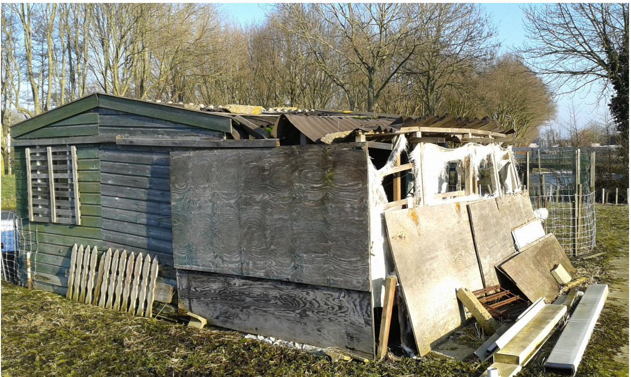
Figuur 3. De schuur op de westkop van de kavel. De muren bestaan uit enkel hout met als dak golfplaten.
