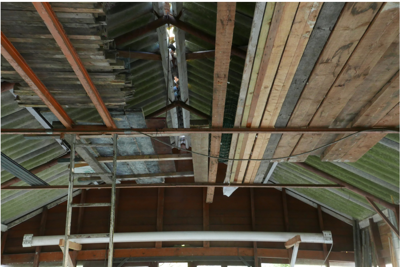
Afb.2: Binnenzijde van de te slopen schuur. Golfplaten dak, enkelwandige muren en raamloos. Niet geschikt voor vleermuizen.
