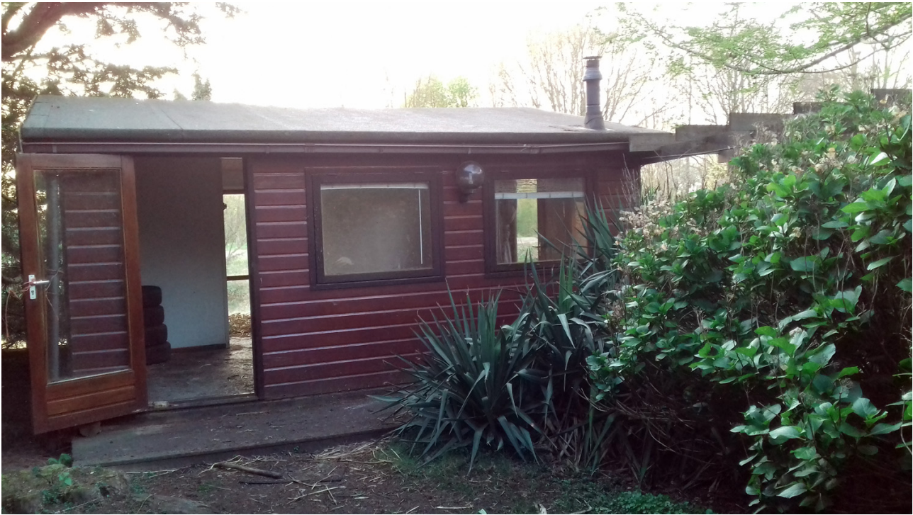
Afb.3: Buitenzijde van het te slopen 'kantoortje'. Bitumen dak, enkelwandige muren. Niet geschikt voor vleermuizen.
