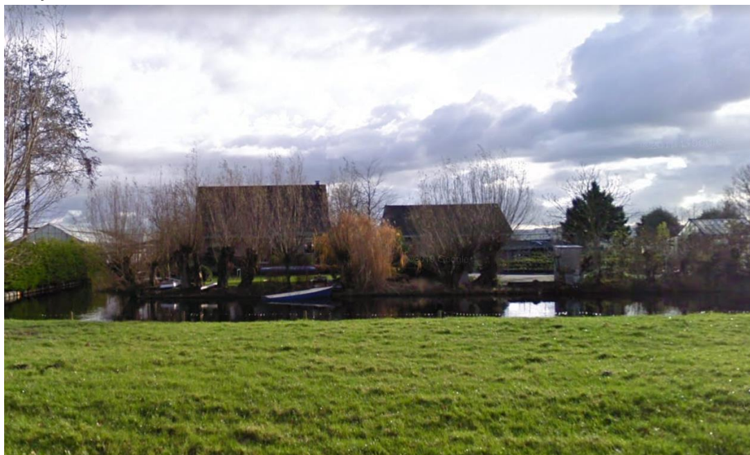
Afbeelding 5: Bedrijfswoning met bijbehorende bouwwerken Vuurlijn 21
