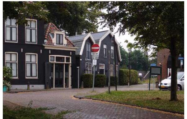
Lintbebouwing langs de Schans
