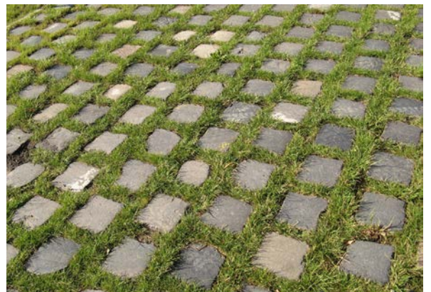
Verharding parkeerplaatsen, natuursteen met gras
