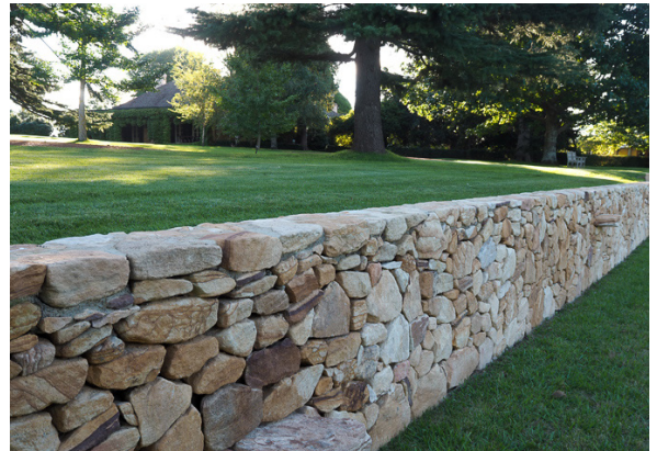
Natuurstenen stapelmuur rond parkeercoffers
