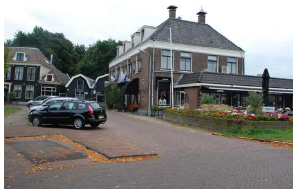
Rechthuis langs de Amstel (gebouwd 1780)
