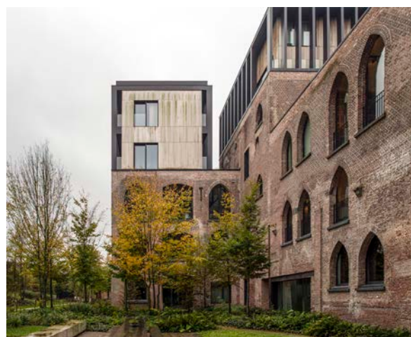
Referentie: Site vervoort Wijnegem, Cousse-Goris- Huygen Architecten, verband bestaand-nieuw
