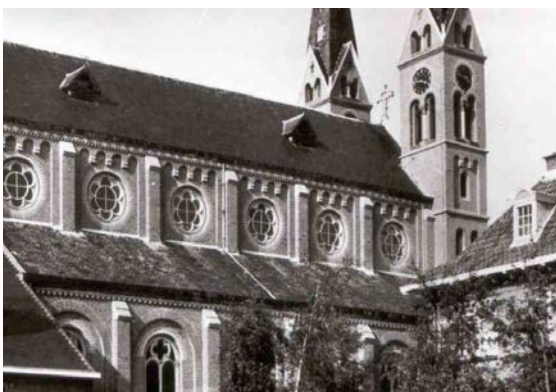
Bestaande plasticiteit in de gevel van de Schanskerk
