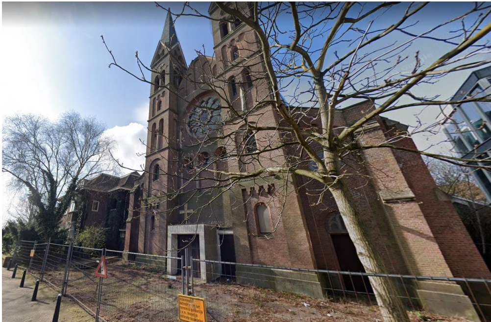
Bestaande situatie Schanskerk
