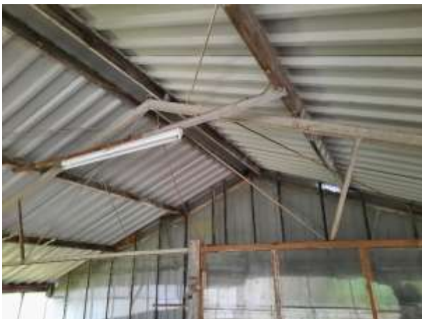
De schuur is bekleed en gedekt met stalen damwandplaten en vormt geen potentiële verblijfplaats voor vleermuizen.
