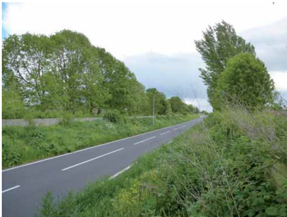
Foto 3: impressie bestaande busbaan tussen de straat Aan de Zoom en de toekomstige halte Dorpscentrum
