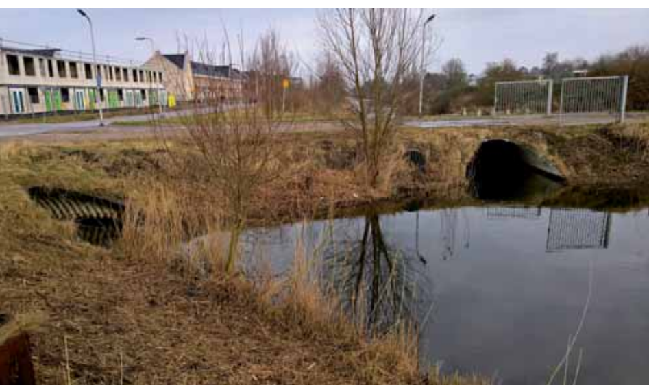
Afbeelding 11. Ecotunnel en duiker maken het verlengde fietspad/autoweg in de huidige en toekomstige situatie passeerbaar voor vissen, amfibieën en zoogdieren.
