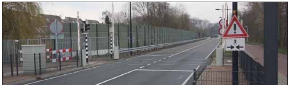
Figuur 2: Bestaande geluidsschermen tussen bij de busbaan voor de Weegbree
