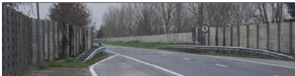
Figuur 4: Bestaande zichtschermen bij de busbaan tussen Boerlagelaan en Amsterdamseweg
