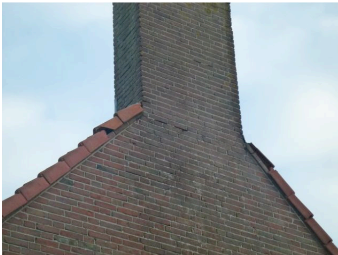
kopgevel met kapotte gevelpannen; veel ruimte voor vleermuizen en gierzwaluw
