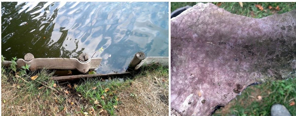
Afbeelding 3: Locatie en detail aangetroffen beschoeiing nabij watergang
