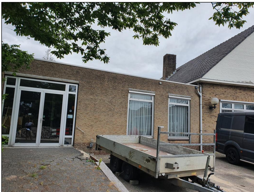
Figuur 3 Het noordelijke deel van de Kerklaan 26-28 bestaande uit een enkele bouwlaag.
