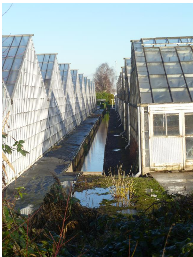
Foto noordelijk vanaf parkeerterrein aan Vuurlijn
