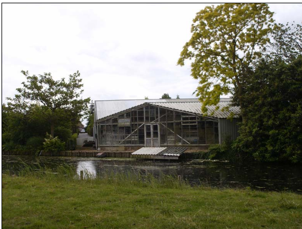
Foto 3: Plangebied gezien in zuid-oostelijke richting vanaf de openbare weg "Vuurlijn"
