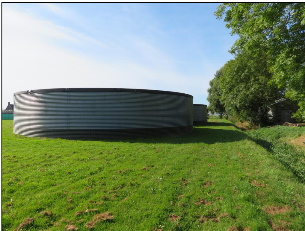
Figuur 2 De planlocatie betreft twee silo's.
