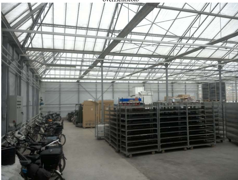
te verwijderen opstallen (gedeeltelijk)
