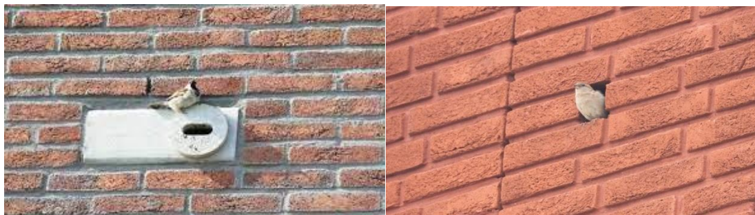
Afbeelding 8: een permanente compensatie voor de huismussen. Stenen ingemetseld in de spouwmuur. Links zonder steenstrips, rechts met steenstrips.
