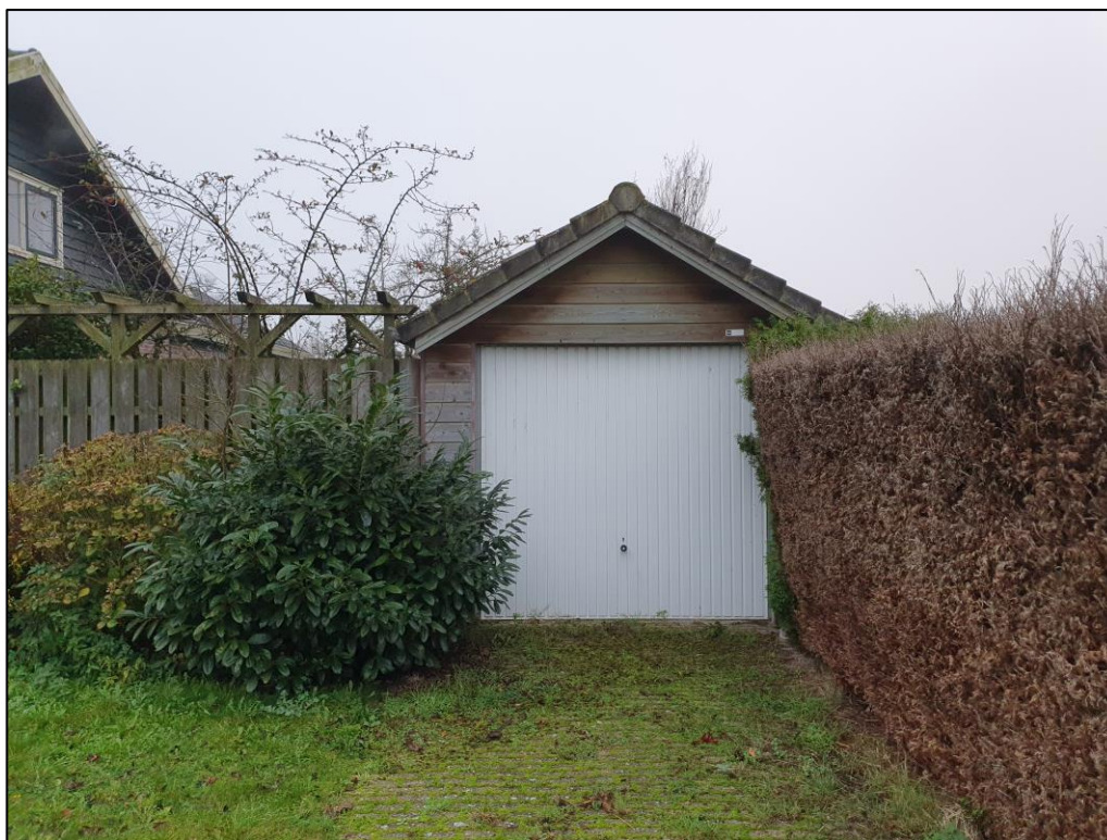
Figuur 3 Het bijgebouw betreft een schuur opgetrokken uit houten wanden met een zadelpannendak.
