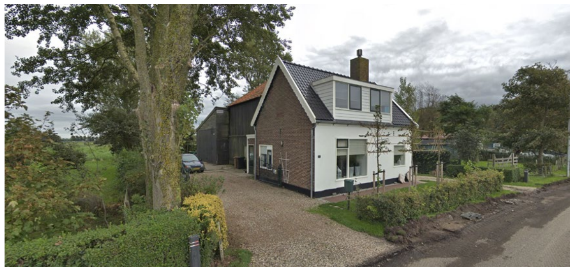
Boerenerf Uitgeesterweg 19 met woning aan voorzijde van het erf, hagen en leibomen op voorerf, en bedrijfsgebouwen achter op het erf.
