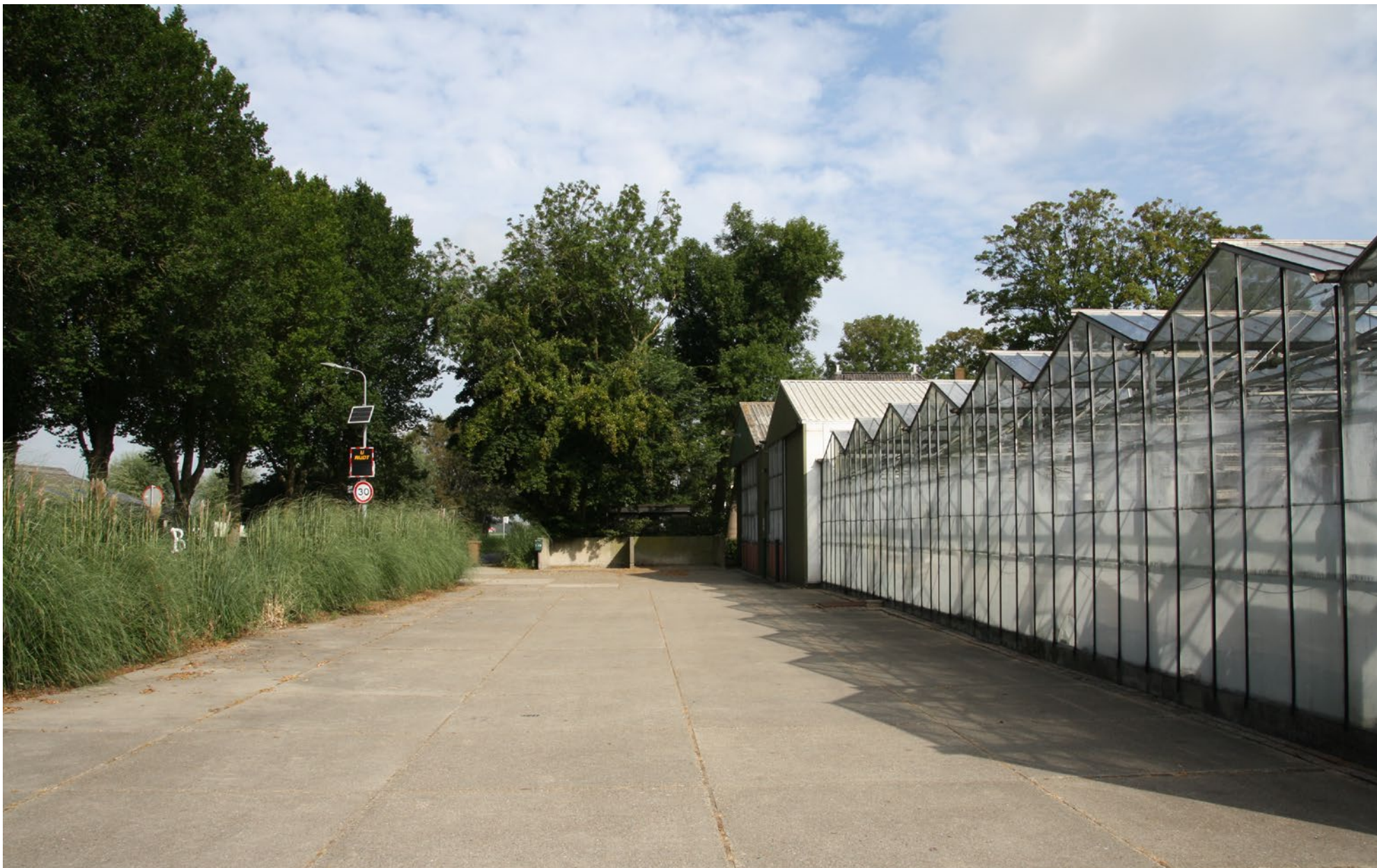
Voorkant van het bedrijfserf met veel verharding en leegstaande kassen en bedrijfsgebouwen.
