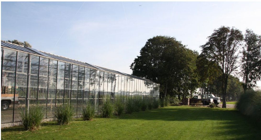
Zuidgevel van de kassen, aansluiting op tuin rondom bedrijfswoning
