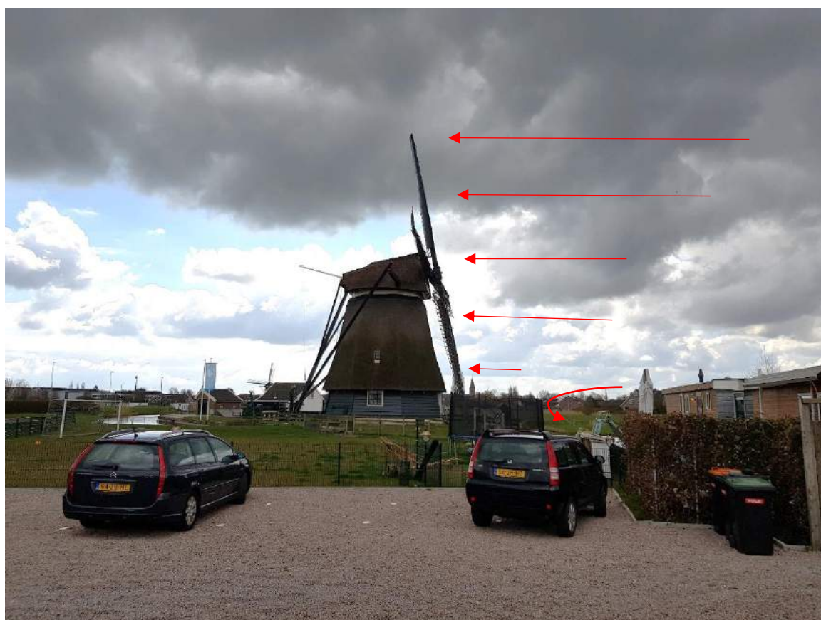
Afbeelding 1: Molen De Dog. De rode pijlen geven een beeld van de relatieve windsnelheden verdeeld over de hoogte van het gevlucht. Achter een gebouw ontstaan lage druk gebieden met draaiingen in de luchtstroom als gevolg.
