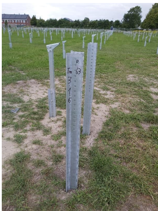
Foto 1 t/m 4: toepassing rampalen bij zonnepark in aanbouw
