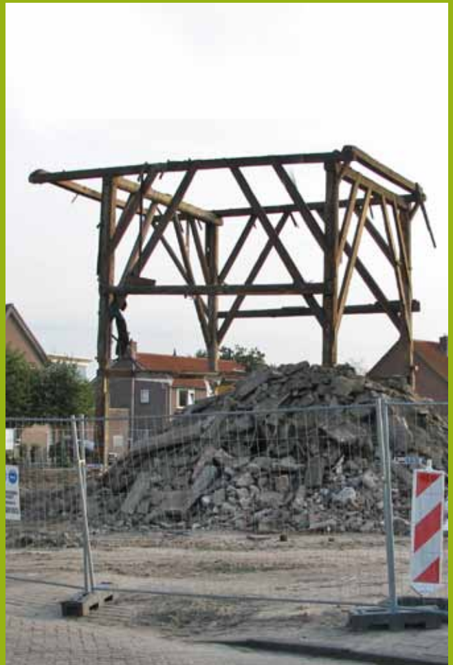
Vierkants-dekbalkgebit met overstekken.
