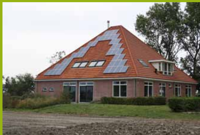
Aantasting van stolpdaken door zonnecollectoren.
