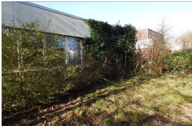
De bebouwing betreft een laagbouw met één verdieping.
