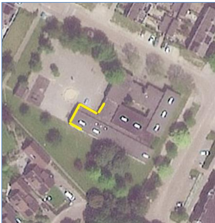
Figuur 2: In geel de locaties van het pand met open stootvoegen die potentieel geschikte verblijfplaatsen voor gebouwbewonende vleermuizen bevatten
