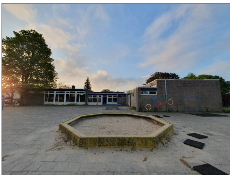
Figuur 2: Huidige situatie gezien vanaf het schoolplein (west)
