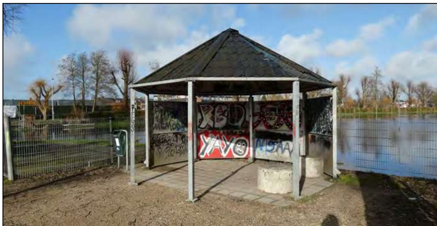
Figuur: de overkapping aan de zuidzijde is ongeschikt voor huismus, gierzwaluw en vleermuizen. Er zijn geen geschikte openingen of spleetvormige ruimten.
